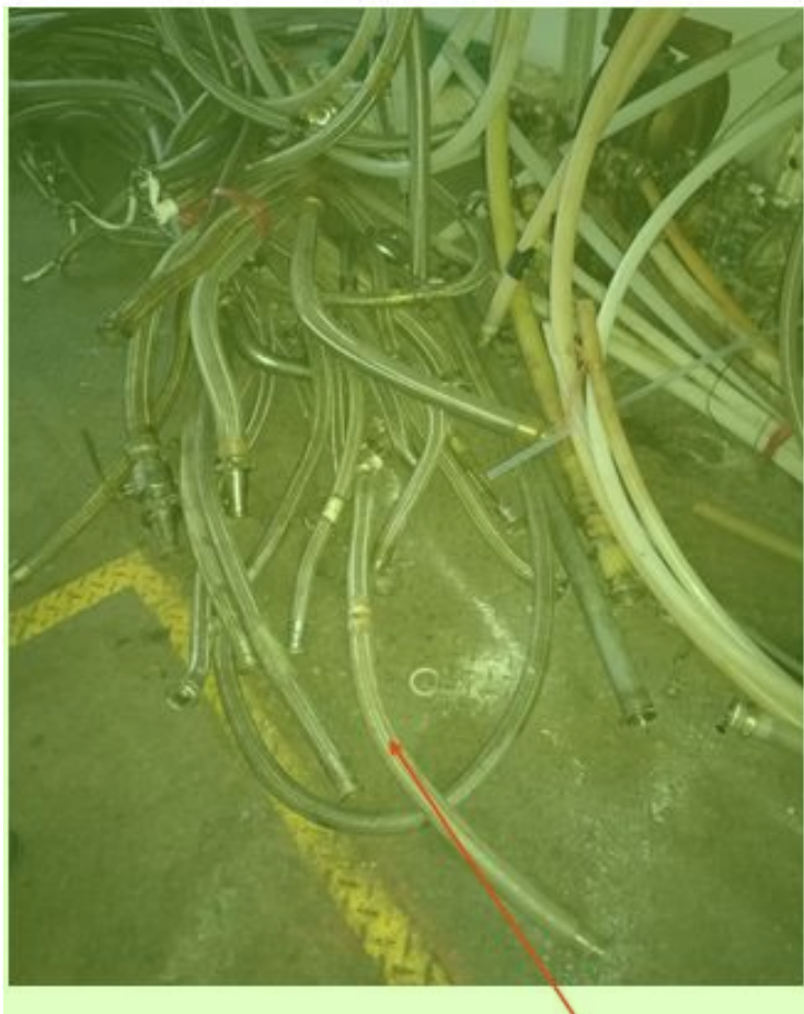
101 车间氮气吹扫所有连接管道 1
